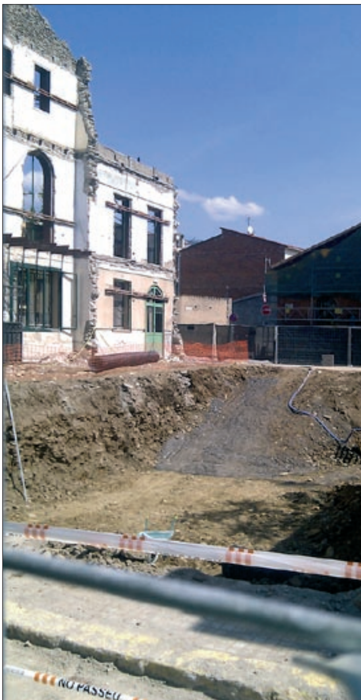
Maynou instal·larà la geotèrmia a l'ajuntament de Santa Maria de Palautordera
